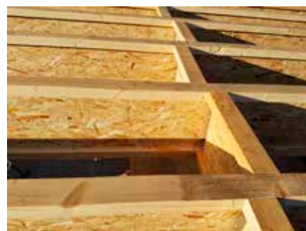
Výztuhy z výřezů I-nosníků
