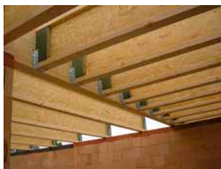
Uložení krokve na pozednici – I-nosník podložený dřevěným klínkem při větším sklonu střechy
