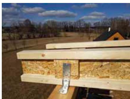
Uložení krokve na pozednici – I-nosník podložený dřevěným klínkem při větším sklonu střechy
